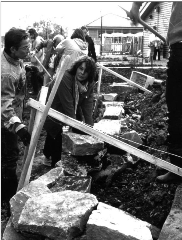
*Aufschichtung von Natursteinen zu einer Stützmauer. Hinter den Steinen muss als „Dränage“ Lockergestein eingebracht werden. Wärmeliebende Tiere wie die Zauneidechse finden hier Unterschlupf.*
