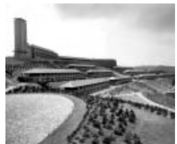
Die monumentale Burg Vogelsang könnte zum Teil als Nationalpark-Infozentrum genutzt werden. Weitere Projekte, z.B. ein Europäisches Begegnungszentrum, sind möglich. Foto: Förderverein Nationalpark Eifel
