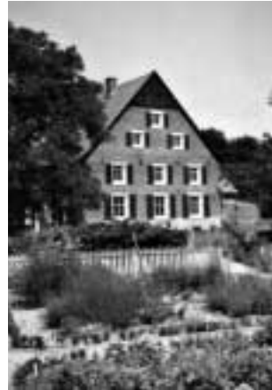
Gebäude der Bio-Station Kreis Recklinghausen in Dorsten
