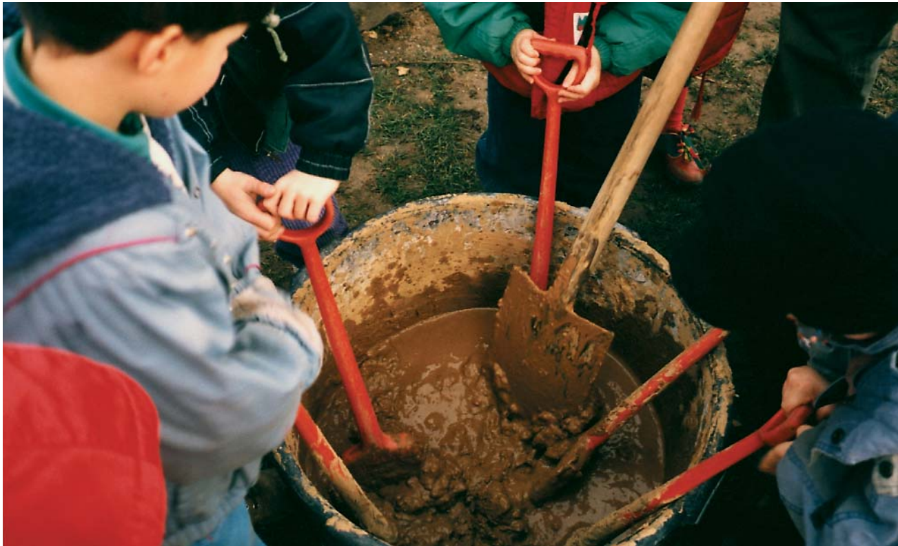
Bau einer Insektennistwand aus Lehm im Städtischen Kindergarten Heiligenhaus-Isenbügel mit einem Mörtel aus Lehm, Kuhmist (frisch vom Bauern), geschnittenem Heu, Stroh und Wasser sowie einem Holzgeflecht aus Haselnuß-Zweigen.
