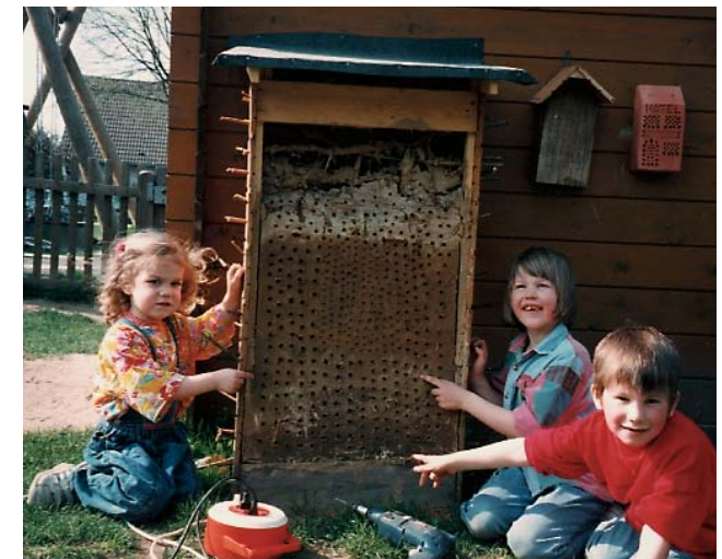
Bau einer Insektennistwand aus Lehm im Städtischen Kindergarten Heiligenhaus-Isenbügel mit einem Mörtel aus Lehm, Kuhmist (frisch vom Bauern), geschnittenem Heu, Stroh und Wasser sowie einem Holzgeflecht aus Haselnuß-Zweigen.
